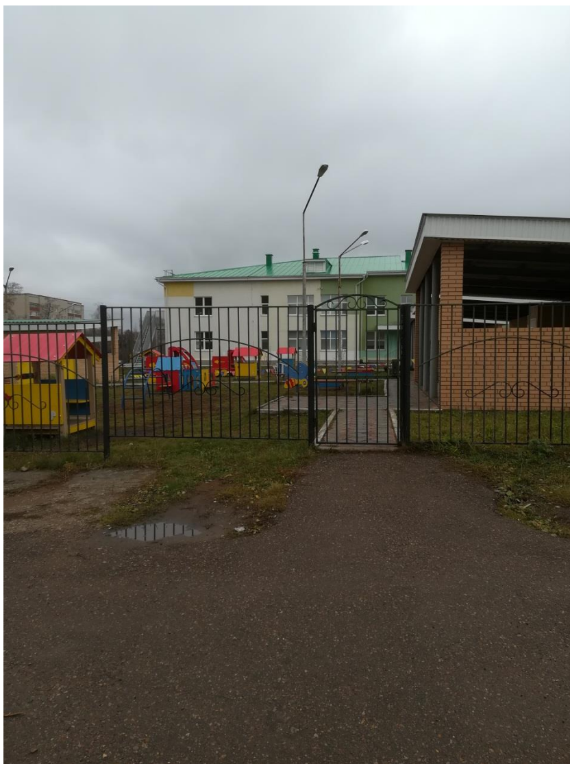
Автостоянка и парковка к детскому саду Фото№17
